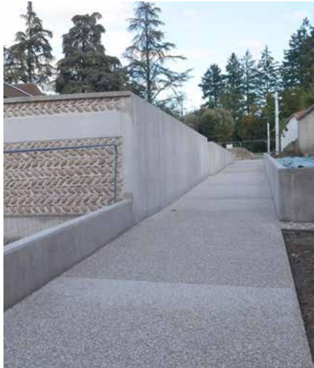
*Chemin piétons - réalisation d'un mur en galets roulés*
