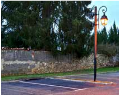
Rénovation de l'enrobé du parking de la mairie
