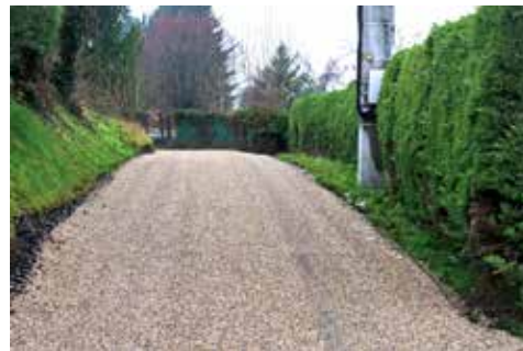
Goudronnage du chemin de la Châtaigneraie (lieu dit La Montet)
