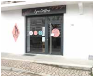
Réfection du trottoir et de l'accès PMR devant le salon de coiffure
