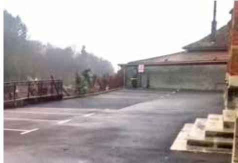
Rénovation de l'enrobé et de la barrière du parking de l'église
