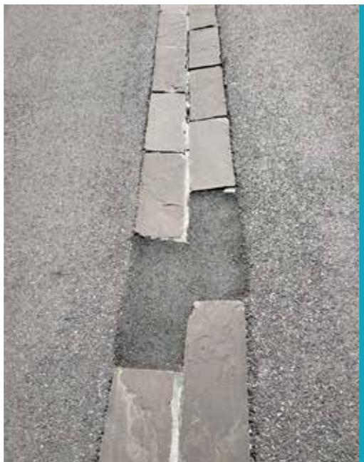
*Pavés descellés remplacés provisoirement par du goudron
