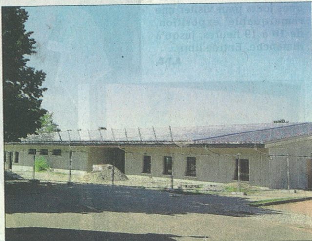
424 panneaux photovoltaïques ont été installés sur le toit.
