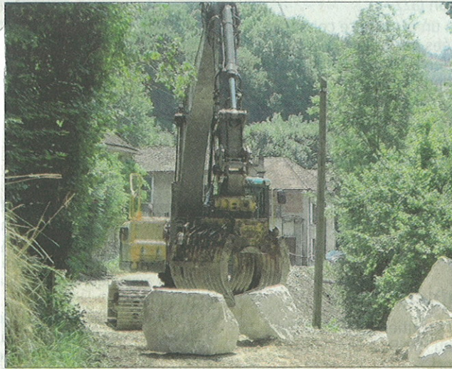
D'énormes blocs de rocher ont été nécessaires.
