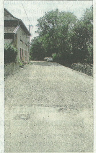
Une vue après les travaux.
