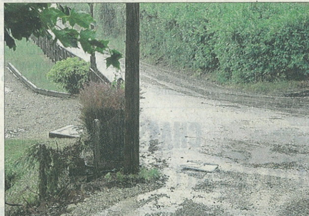
La route s'est transformée en ruisseau.
