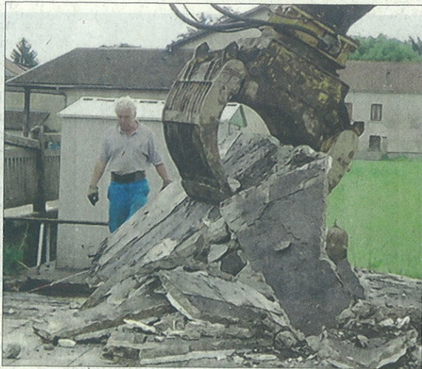
La pelleteuse n'a fait qu'une bouchée du chalet détruit par le feu.
